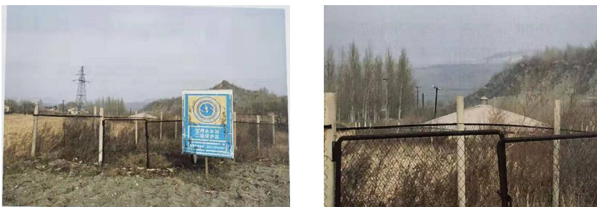
图 3.1-14 玉泉镇红石泵站水源井现状图
